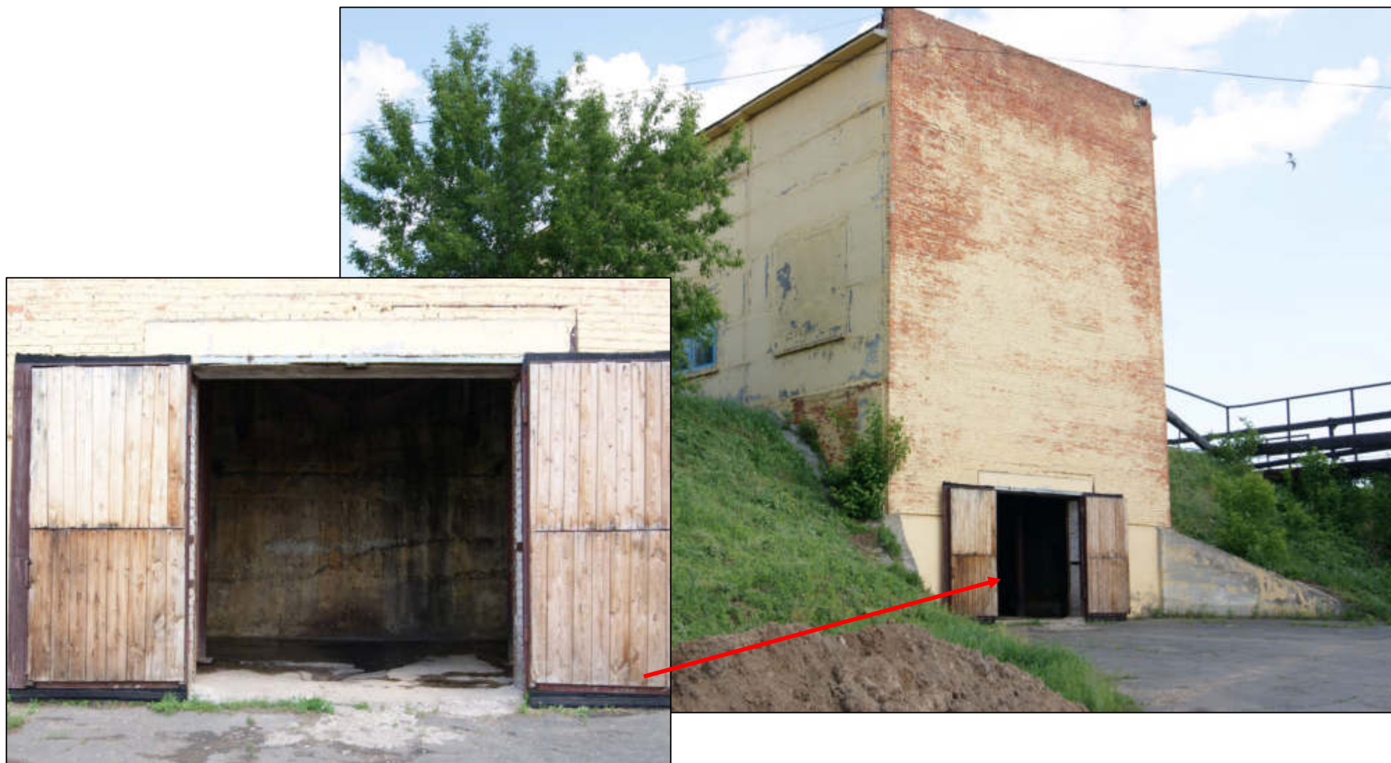
Рисунок 1.42 Задний фасад здания решёток с входом в мусоросборник.
