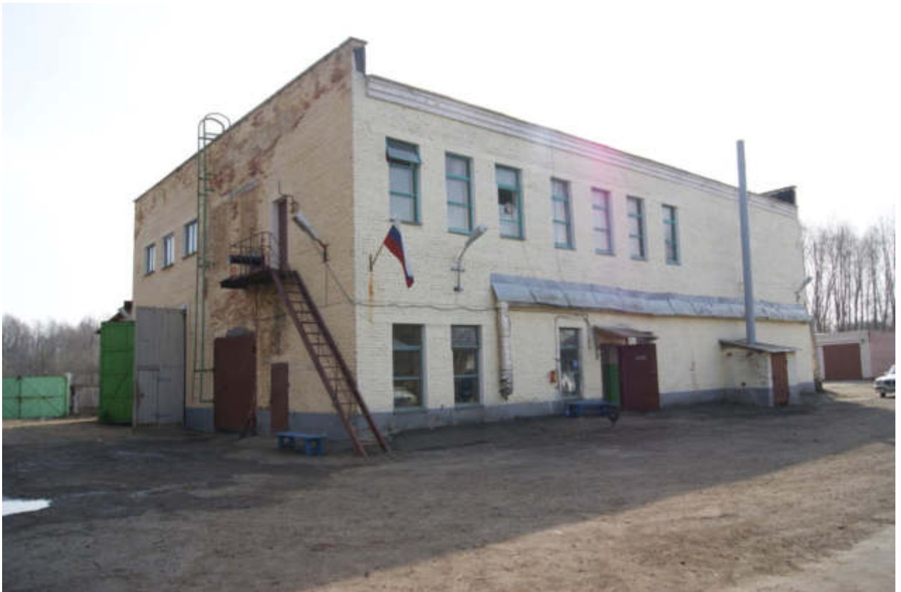
Рисунок 1.14 Фасад здания с центральным входом КНС-5
