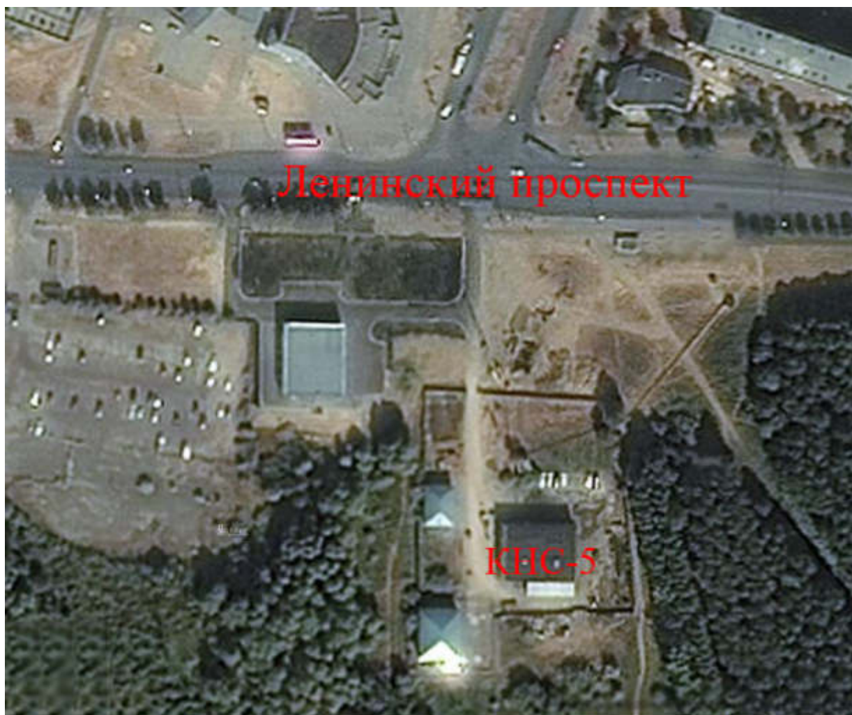
Рисунок 1.13 Вид сверху канализационной насосной станции №5
