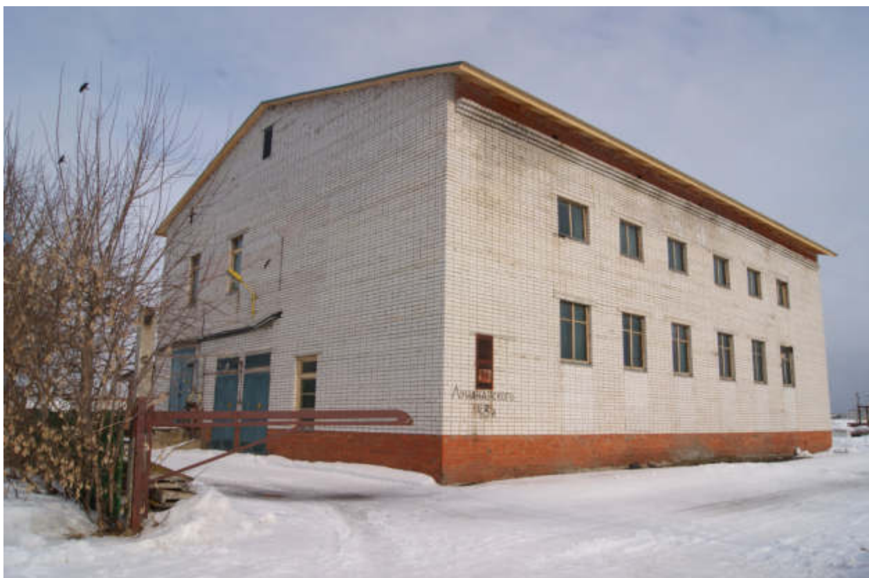
Рисунок 1.31 Фасад здания со стороны въезда на территорию КНС-2
