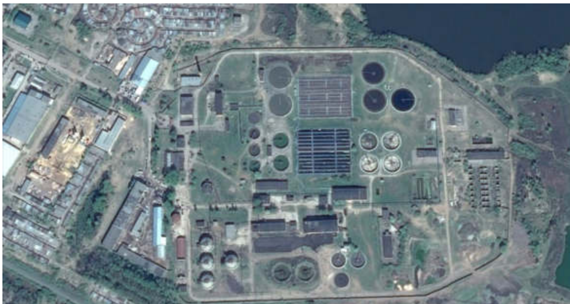
Рисунок 1.38 Канализационные очистные сооружения города Йошкар-Ола.
