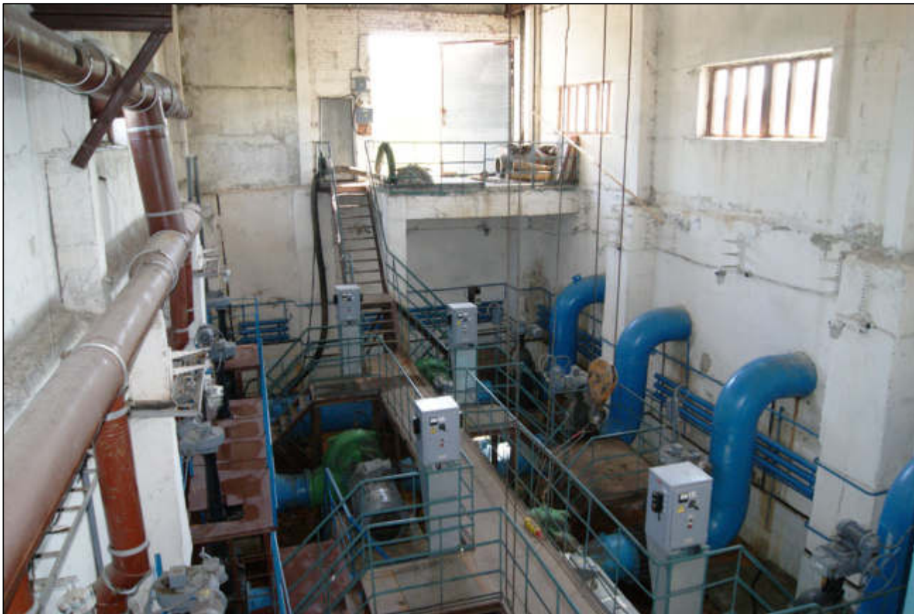
Рисунок 1.51 Машинное отделение НС активного ила.
